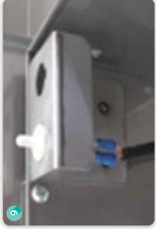
센서공사 및 월페드 알림 점검
